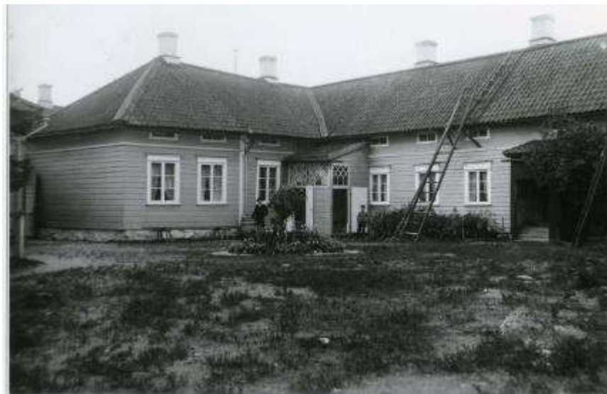
Kuva 29. Kruukun pihaketo on laaja valokuvassa, joka on luultavasti otettu 1800-luvun lopussa. Portilta johtaa sisäänkäyntineille suorat tallatut käytävät. Seinustalla on pitkä pukkijalkainen penkki ja sadevesitynnynri ja istutuksia, ehkä isännän tupakat tai koristeistutus. Sisäänkäyntien lähellä keskellä aukeaa pihaa on koristeistutus eli kukkarundelli. Toisen kuistin vieressä näkyy matalan pihapuun oksa.
