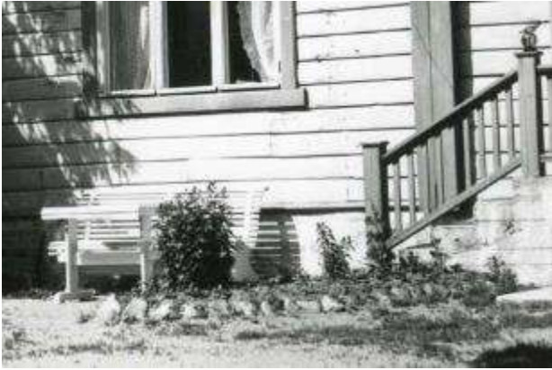
Kuva 32. Nuorempi tulkinta kivillä reunustetusta rundellista, kukkaringistä on kuvattu Katula / Wähä Knuutla sisäpiha vuonna 1941. Sen reunuksena on epäsäännöllisen muotoisia kiviä, jotka on aseteltu vähän upotettuina matalasti kantattuun kaivantoon. Kasveista voi tunnistaa lupiinin.
